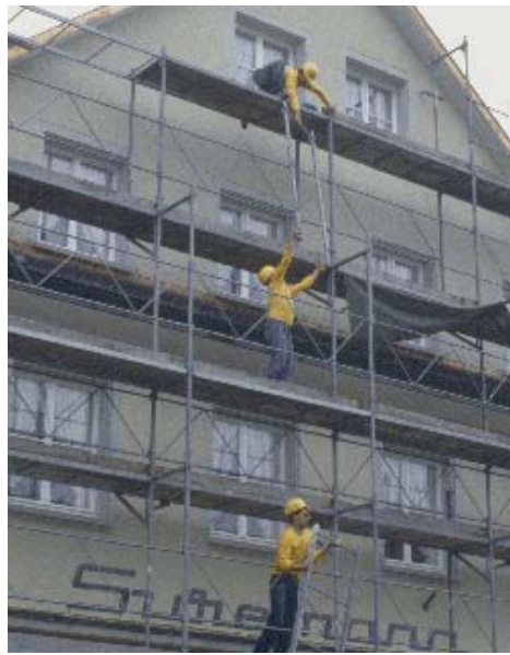
Kaum eine Baustelle ohne Gerüst. Bloss: Ist «Gerüstmonteur» wirklich ein Lehrberuf? Kennen Ihre Schülerinnen und Schüler die Antwort? Foto Heini Gubler
