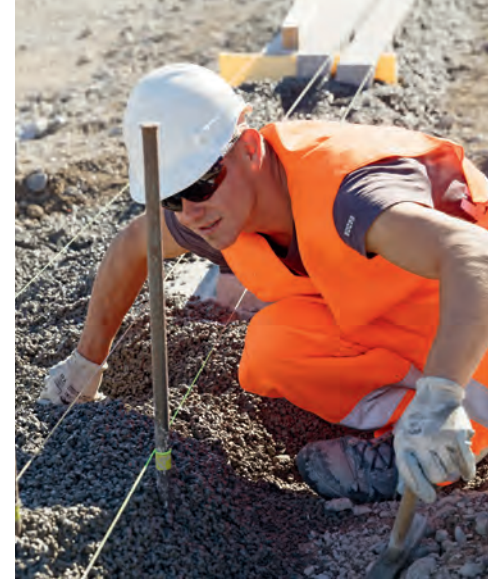
^ Dario Coduri kontrolliert den Verlauf der Richtschnüre.
