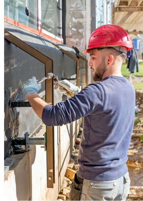
^ Jede Fassade braucht eine gut montierte Unterkonstruktion.
