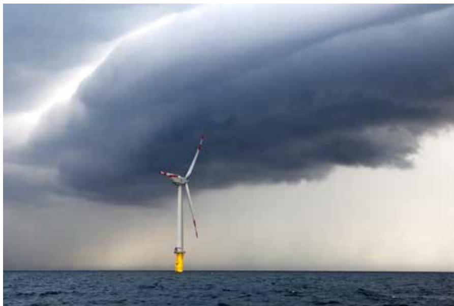
Während «Sabine» wütete, machte die Windenergie rund 65 Prozent der elektrischen Energie Deutschlands aus: Windrad bei der ostfriesischen Insel Borkum.
