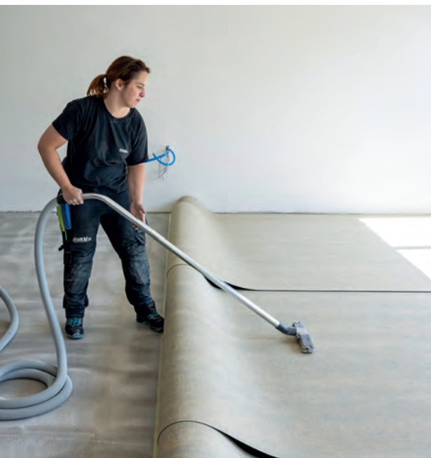
^ Marjorie Oulevey beim Verlegen eines Linoleumbodens.
