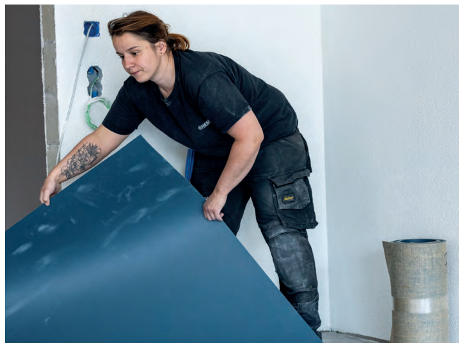
^ Marjorie Oulevey beim Verlegen eines Linoleumbodens.
