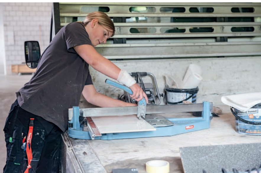
◀ Ronja Durand schneidet die Keramikplatten exakt auf Grösse und Form des Raums zu.
