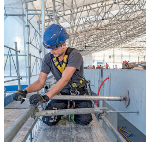
Manuel Hilbi korrigiert den Abstand des Gerüsts zur Wand.
