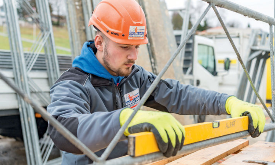
◀ Steht das Gerüst gerade? Sinisa Vukman überprüft sein Werk mit der Wasserwaage.
