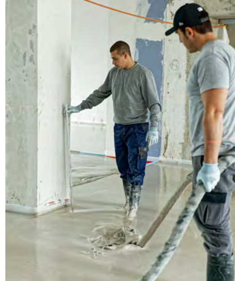
Die Bodendicke wird regelmässig gemessen: Ideal sind in diesem Fall 55 Millimeter.
