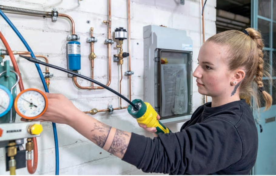
◀ Larissa Tschan setzt den Sensor des Lecksuchgeräts an eine Lötverbindung: Ist diese nicht dicht, piepst das Gerät.
