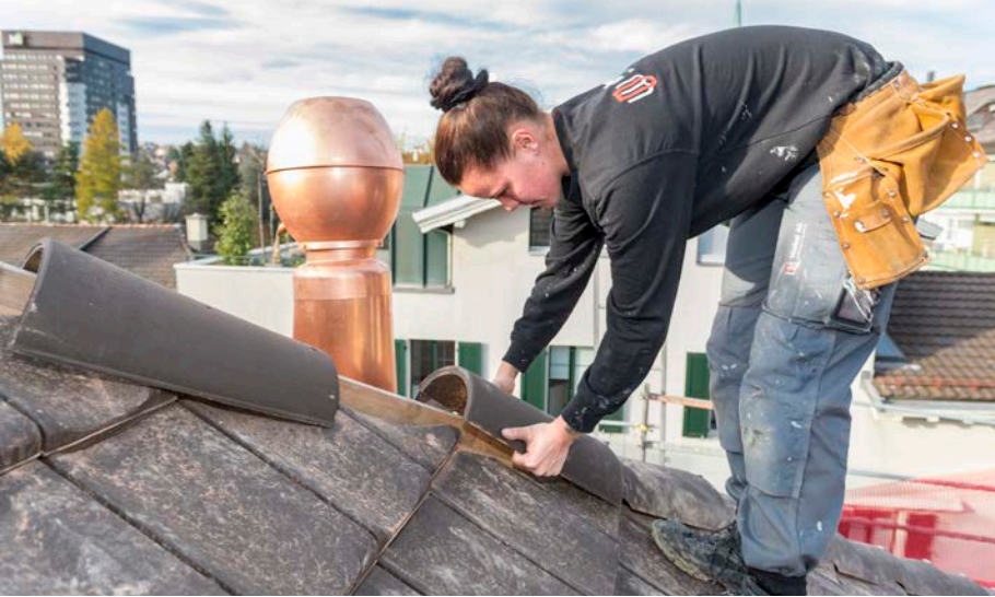
◀ Nadja Fleischli verlegt Dachziegel. Besonders schwierig ist das an den Kanten des Dachs.
