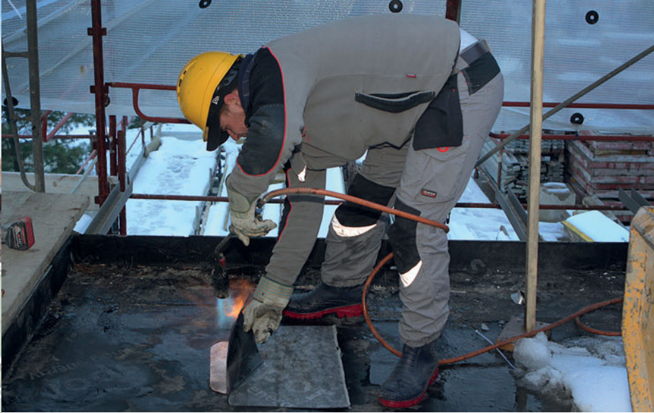
◀ Hitze trifft auf Kälte: Verlegen von Bitumen-Bahnen im Winter.
