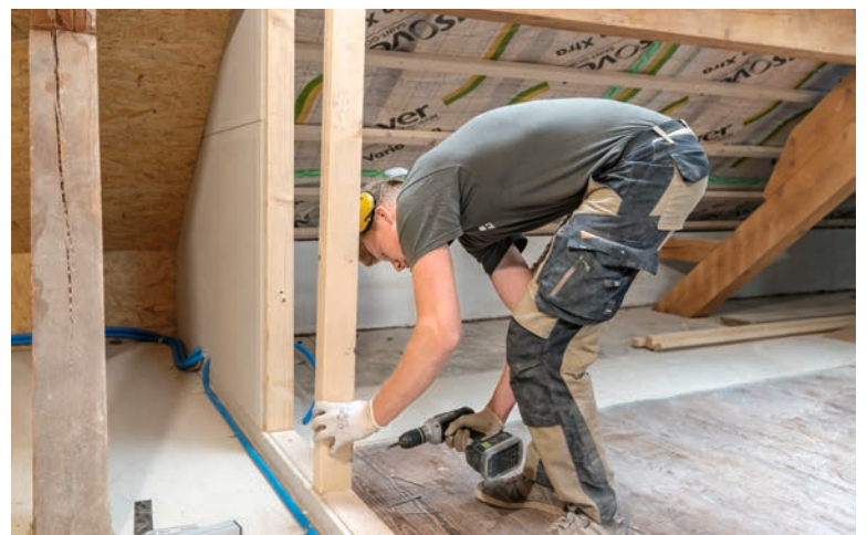
^ Innenausbau Die Berufsleute haben nicht nur auf Dächern zu tun, sondern arbeiten auch in Innenräumen und ziehen zum Beispiel Zwischenwände ein.
