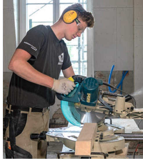
< Sägen und zuschneiden Um einzelne Bauteile zuzuschneiden und einzupassen, setzen Zimmerleute unterschiedliche Werkzeuge ein – zum Beispiel Fräsen und Sägen.
