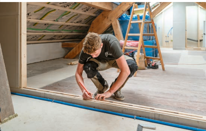
^ Vermessen Holzbauerelemente müssen genau passen, dicht sein und tragende Funktionen erfüllen. Das gelingt nur, wenn die Berufsleute die Räume genau ausmessen.
