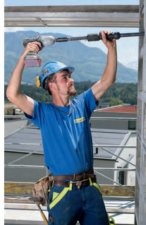
^ Schalungen bestehen unter anderem aus vorgefertigten Metallelementen.
