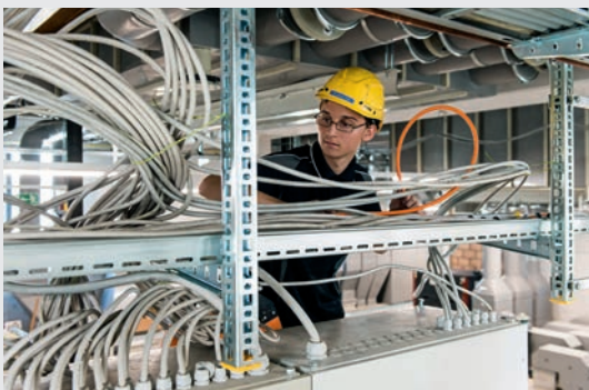
Kabeltrassen installieren Kabeltrassen sind Blechkanäle, auf denen eine grosse Anzahl Kabel verlegt werden kann. Sie kommen in Industriebauten und Technikräumen zum Einsatz.
