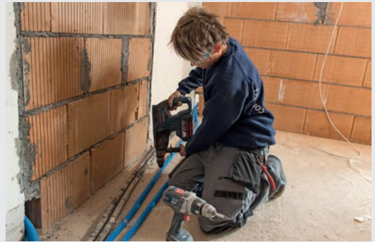
Kabel, Drähte und Steckdosen installieren Kabel in Rohre einziehen oder Steckdosen und Schalter montieren: Solche Arbeiten machen einen grossen Teil des Berufsalltags aus.
