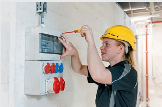
Sicherungskästen montieren Sicherungen verhindern Kurzschlüsse und eine Überlastung der Leitungen im Haus. Sie sind das Herzstück jeder Elektroinstallation.
