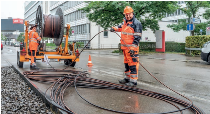
Tomislav Vukovac bereitet ein Glasfaserkabel für den Transport vor.
