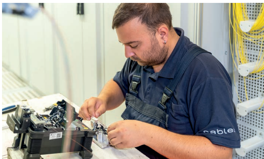
In der Zentrale ist Tomislav Vukovac mit dem Spleissen von Glasfasern beschäftigt.
