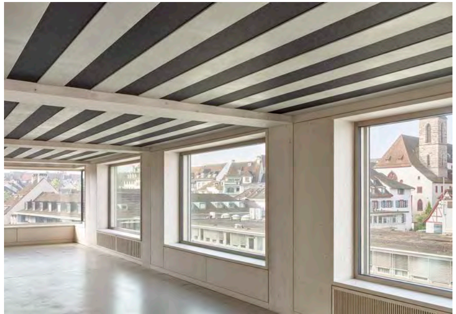
Roher Innenausbau mit hybrider Ausstattung der Bauteile und Oberflächen wie die Holz-Betondecke oder ein Anhydritboden.
