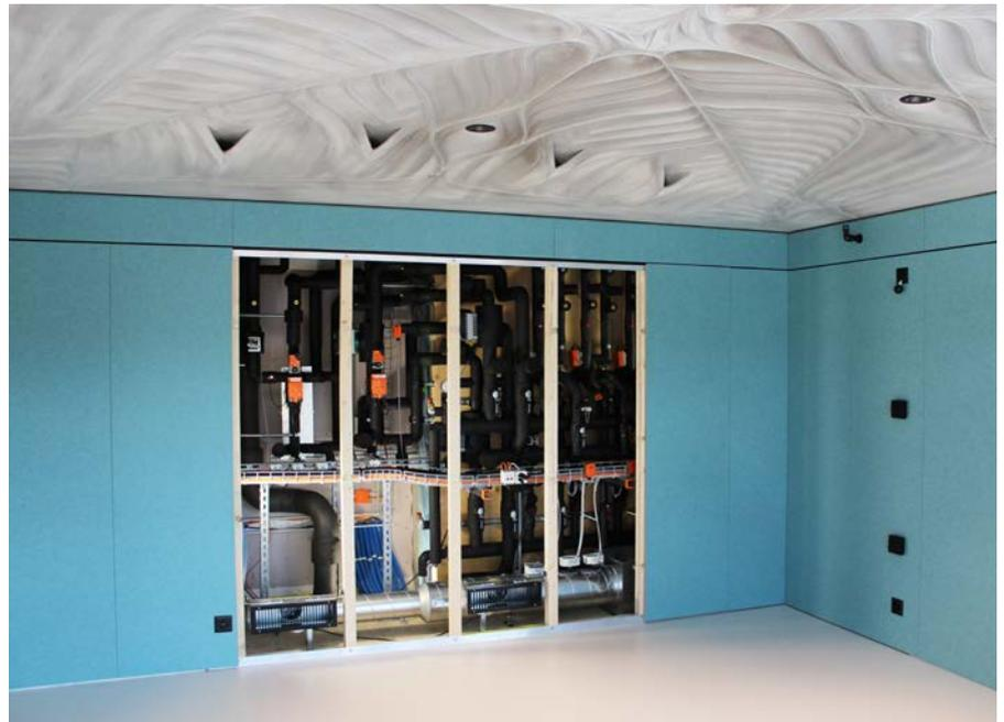
Die eingesetzten digitalen Fertigungsmethoden ermöglichen es, Lüftung, Kühlung und Niedertemperaturheizung in die gerippte Gewölbedecke zu integrieren und damit weiteres Material und Volumen einzusparen.
