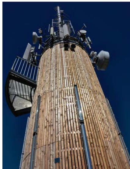
Verkleidungen (hier eines Funkmastes) aus Holz: eines der Spezialgebiete der Holztechnik.
