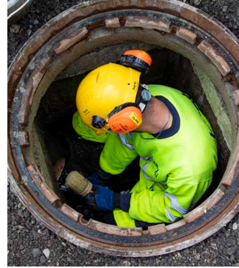
▲ Leitungsarbeiten im Schacht: Eric Estevez kommt mit wenig Platz aus.
